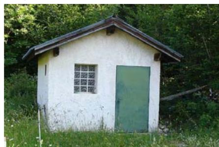
Abritée dans un petit bâtiment en bordure de la route de la Côte, une pompe remonte l'eau du réservoir de la Font jusqu'au hameau des Prés, situé à une altitude supérieure (réservoir : 1140m ; maison Repellin : 1143m ; maison Idelon : 1163m ; maison Bichebois : 1148m).
