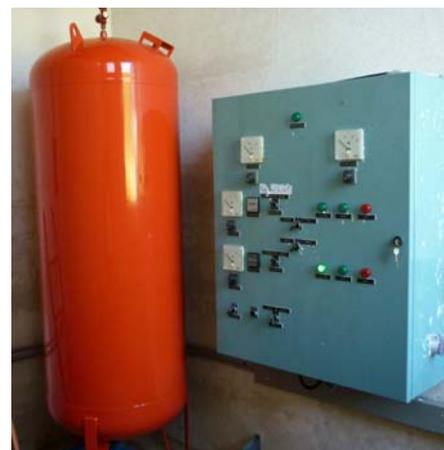
Le ballon surpresseur permet de maintenir une pression suffisante et constante, et évite que la pompe démarre et s'arrête sans cesse, en fonction de l'ouverture d'un robinet. Le ballon d'origine (années 80) fuyait depuis plusieurs années (fuite d'air !), ce qui engendrait des désagréments dans la fourniture d'eau et détériorait les pompes. Un ballon tout neuf et qui conserve son air a été installé récemment. Quelques réglages restent à faire ...
